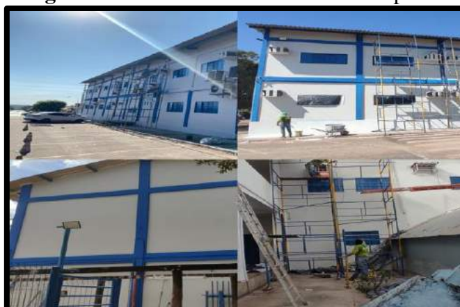
Figura 85 - Melhorias no bloco C – Campus II
