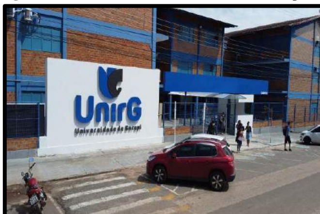
Figura 84 - Melhorias nos blocos A e B – Campus II
