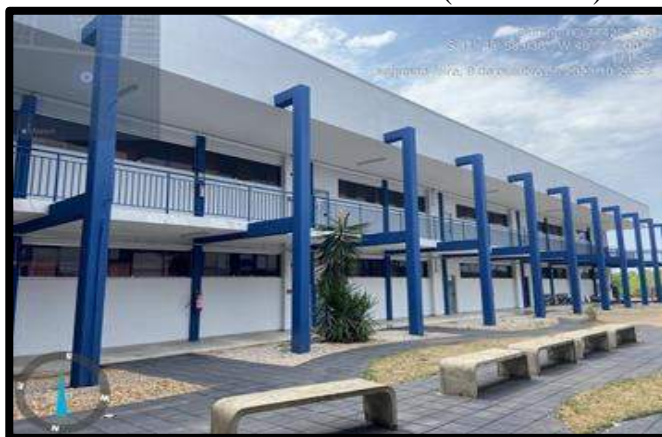
Figura 86 - Reformas dos blocos E e F (andamento) – Campus I
