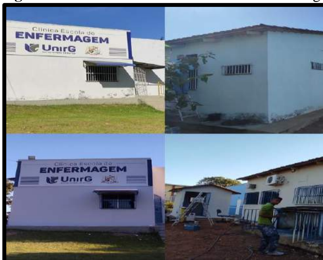
Figura 87 - Pintura da Clínica Escola de Enfermagem
