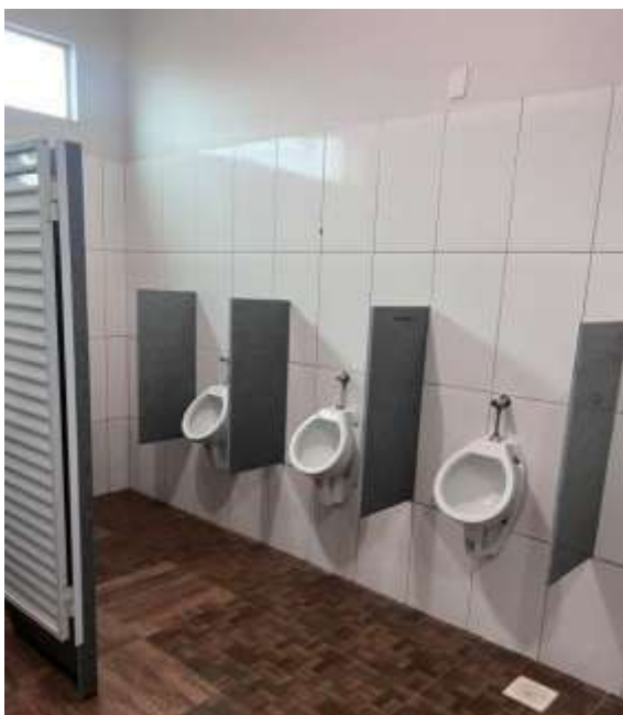
Figura 87 - Banheiro Masculino Unidade II
