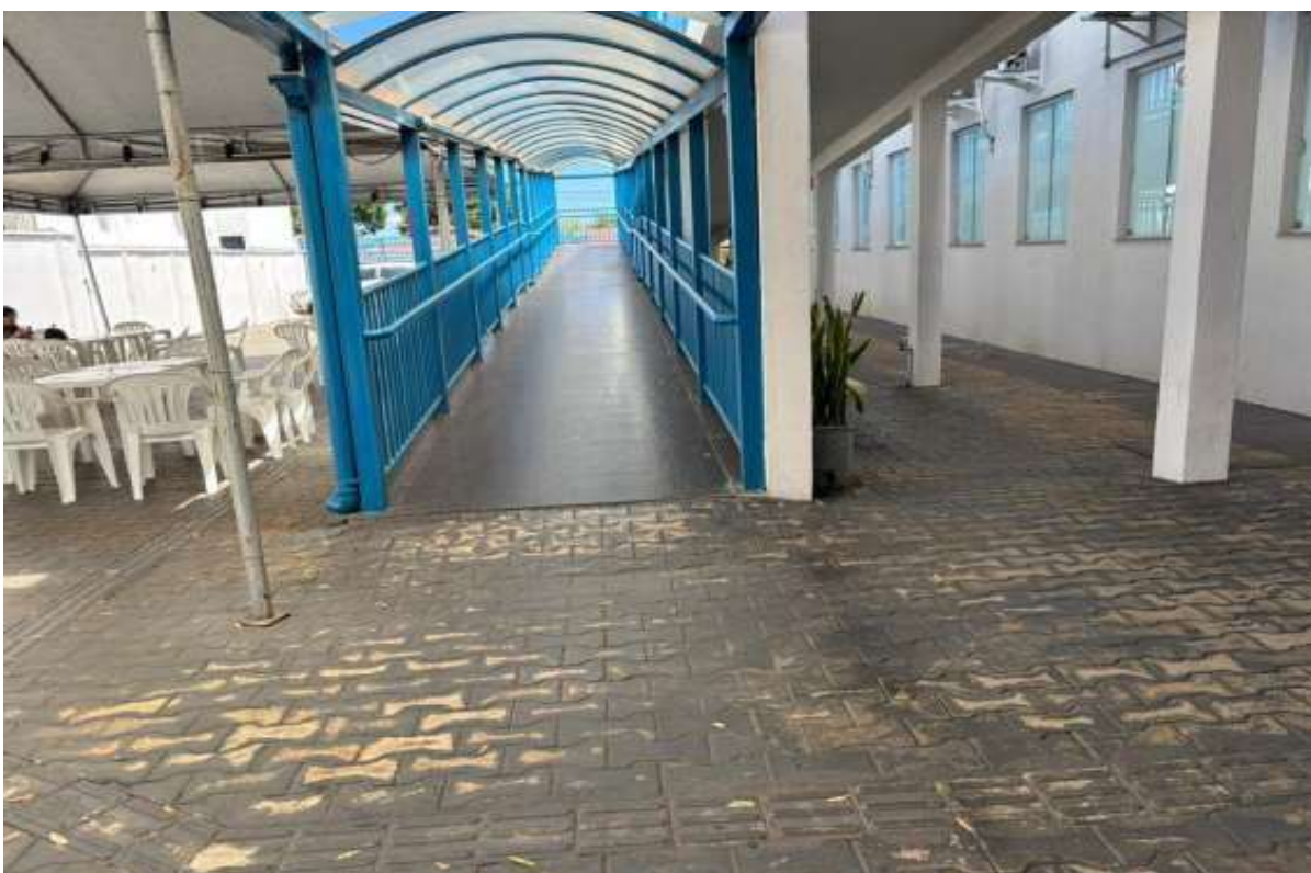
Figura 93 - Rampa de acesso 2º Piso - Unidade I
