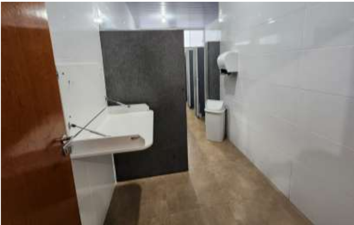
Figura 84 - Banheiro Feminino Unidade I
