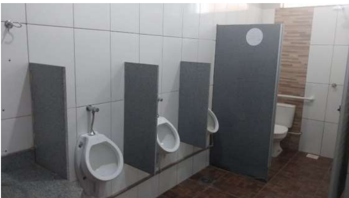
Figura 91 - Banheiro Acessibilidade Masculino Unidade II
