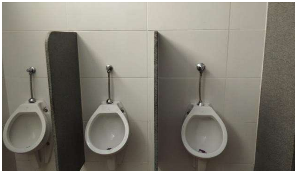
Figura 82 - Banheiro Masculino Unidade I
