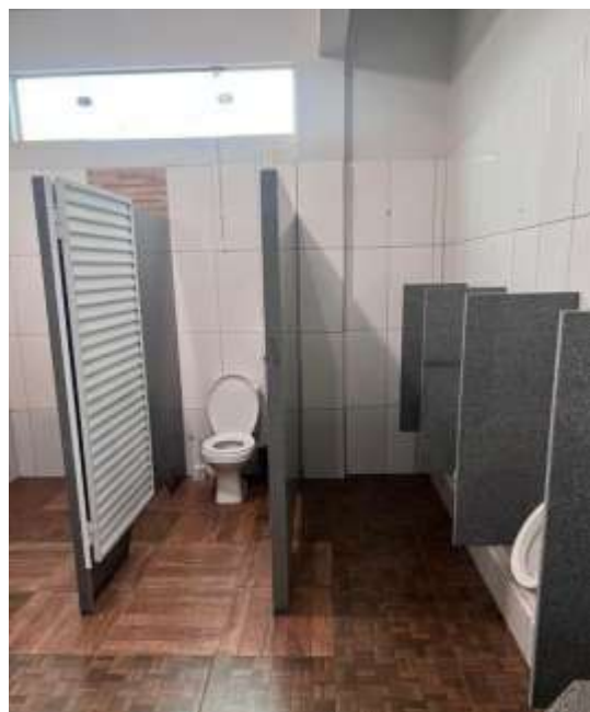
Figura 88 - Banheiro Masculino Unidade II
