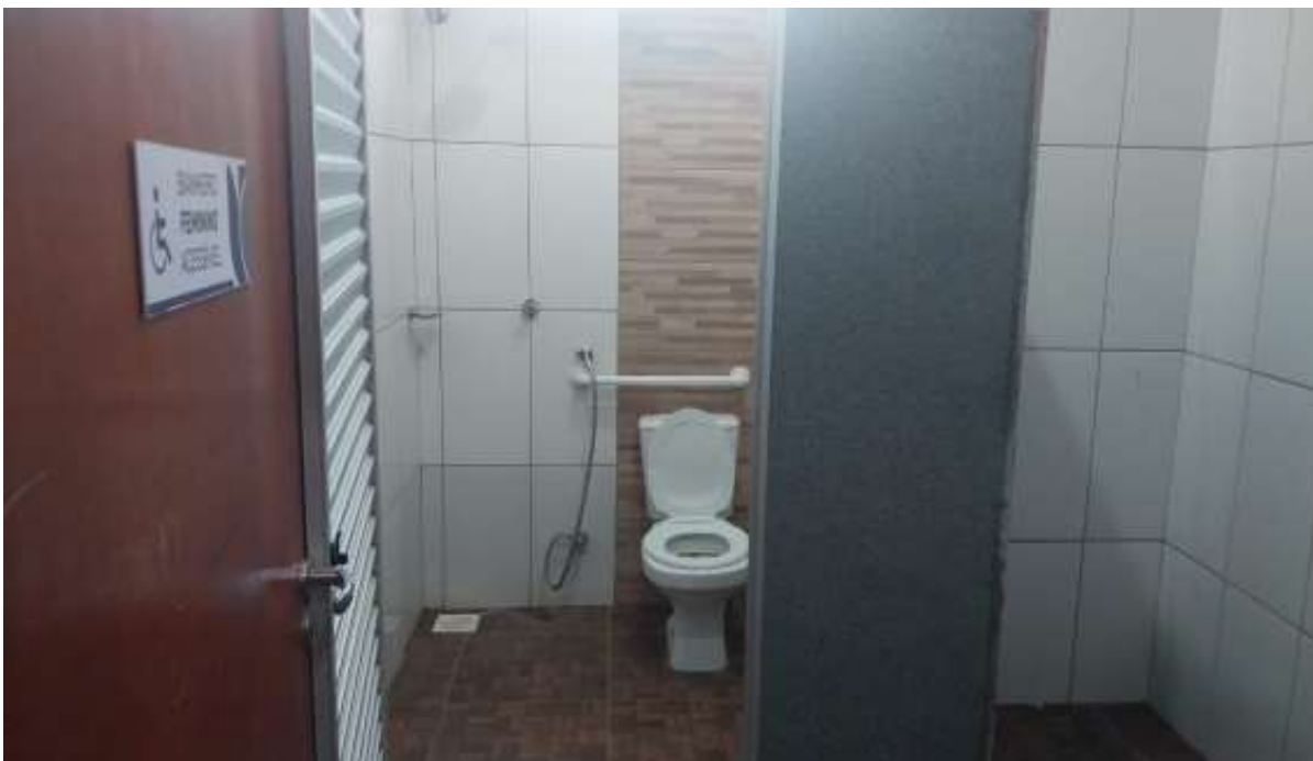
Figura 92 - Banheiro Acessibilidade Feminino Unidade II
