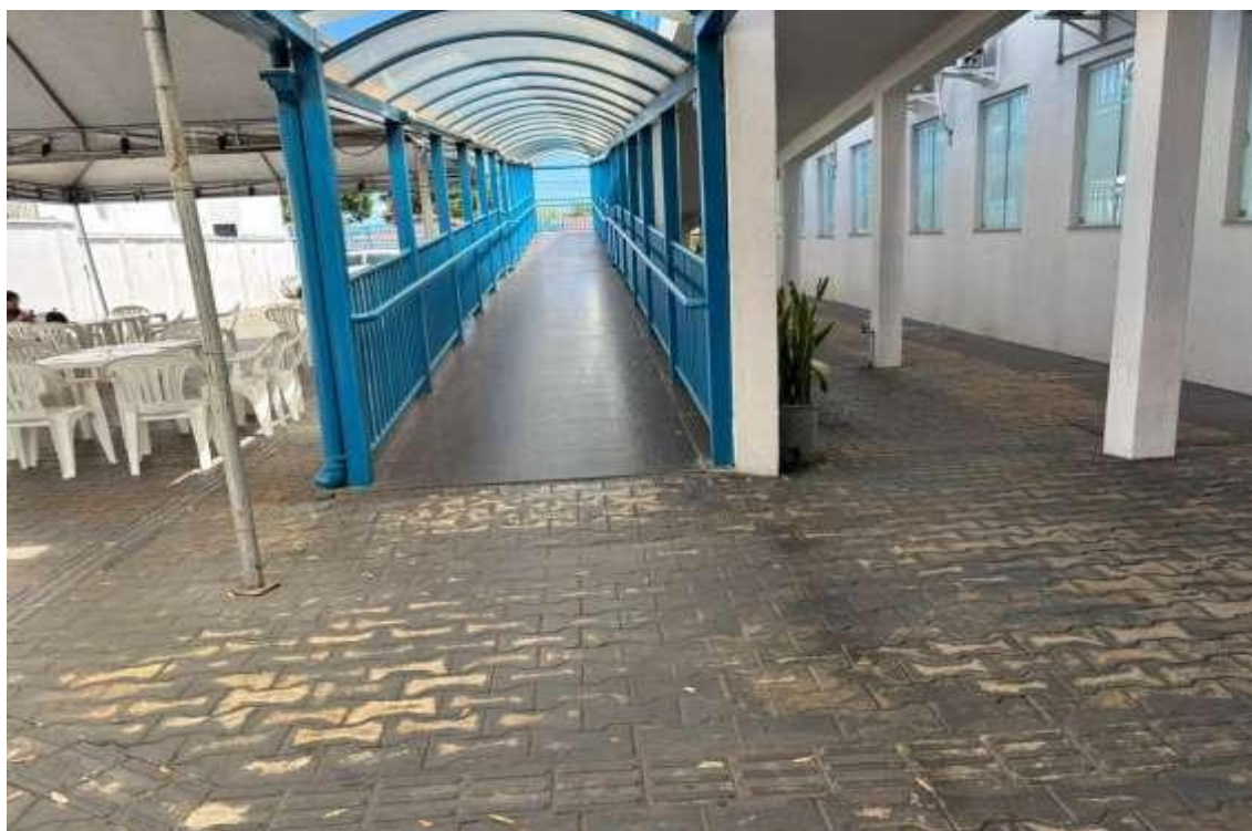
Figura 84 - Rampa de acesso 2º Piso - Unidade I
