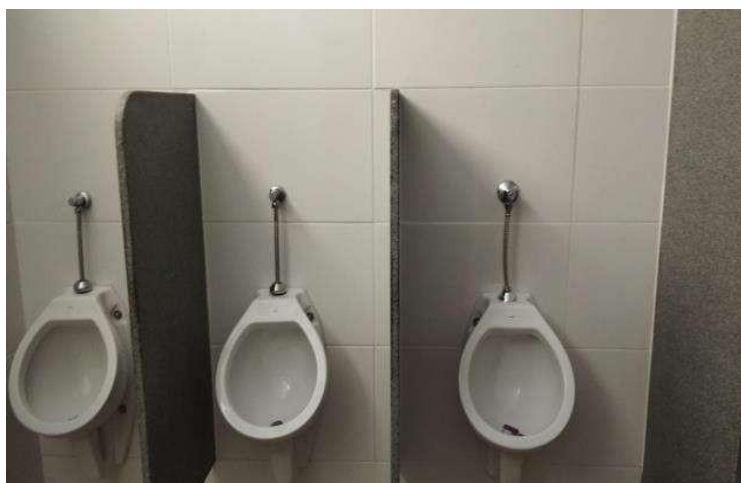
Figura 74 - Banheiro Masculino Unidade I
