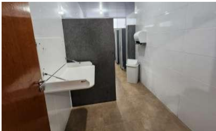
Figura 76 - Banheiro Feminino Unidade I
