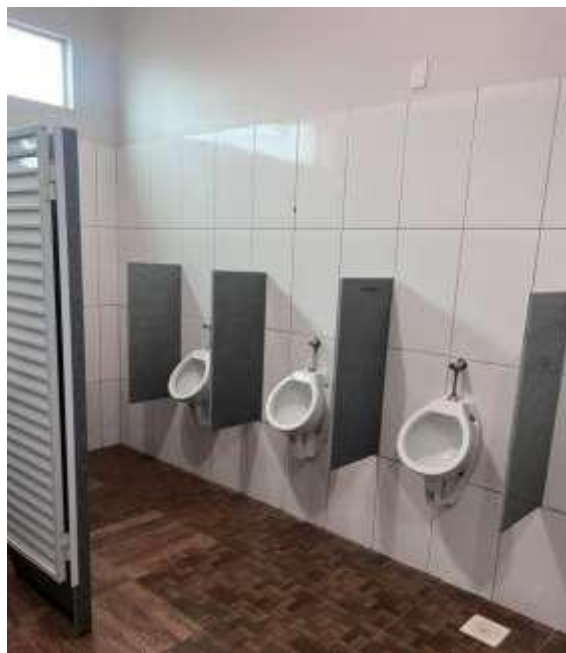
Figura 78 - Banheiro Masculino Unidade II
