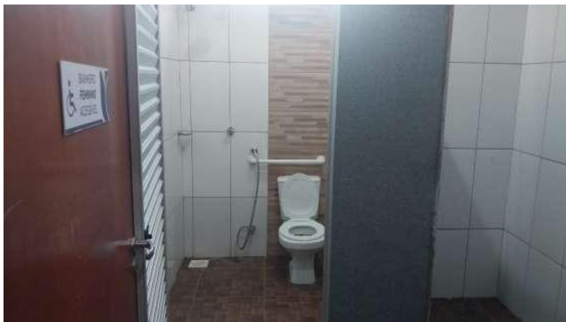
Figura 83 - Banheiro Acessibilidade Feminino Unidade II
