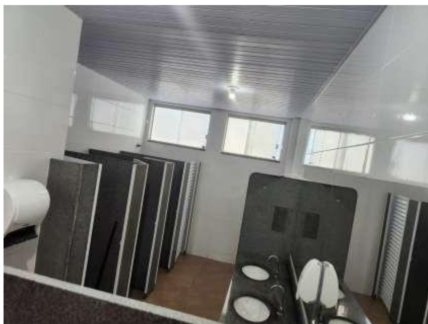
Figura 75 - Banheiro Masculino Unidade I
