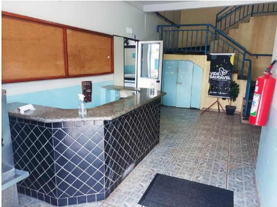
Recepção com bebedor e extintor de incêndio
