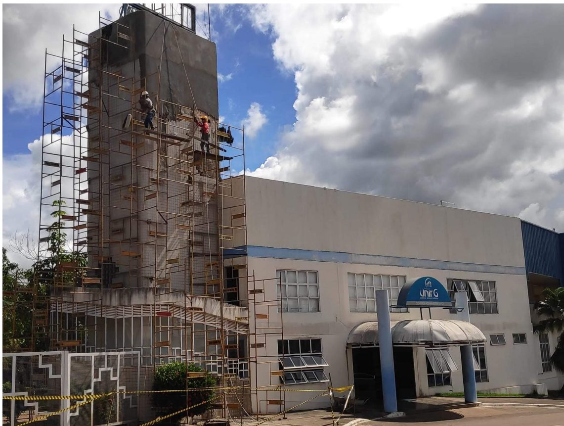
Imagem 31 - Foto 01 – Centro Administrativo
