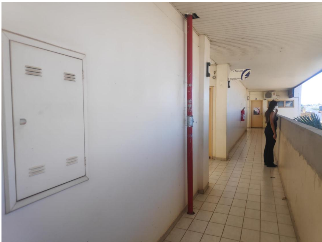
Imagem 33 - Foto 03 – Centro Administrativo
