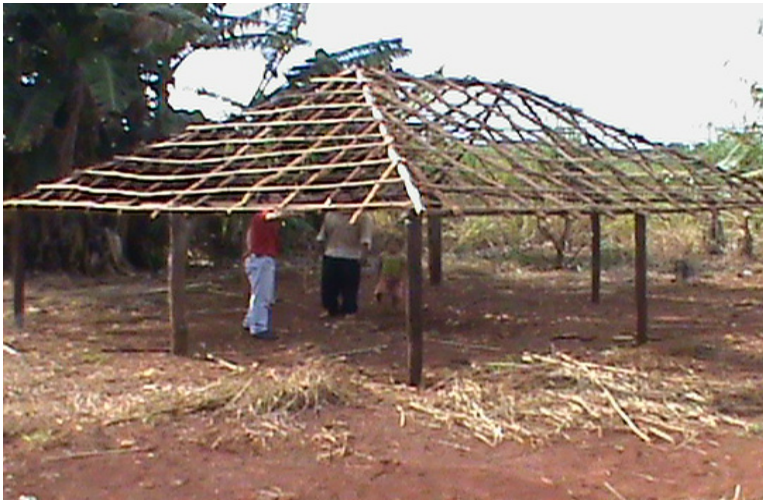
Figura 1: Construção de casa, a qual está em fase de cobertura. Observe que no meio da casa não há o alicerce de sustentação da cobertura. Na foto, o construtor, sua filha e pesquisador. (foto: Odair Rocha Freitas).
